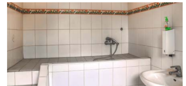
Die Hundedusche seitlich am Sanitärgebäude am Schwimmbad
